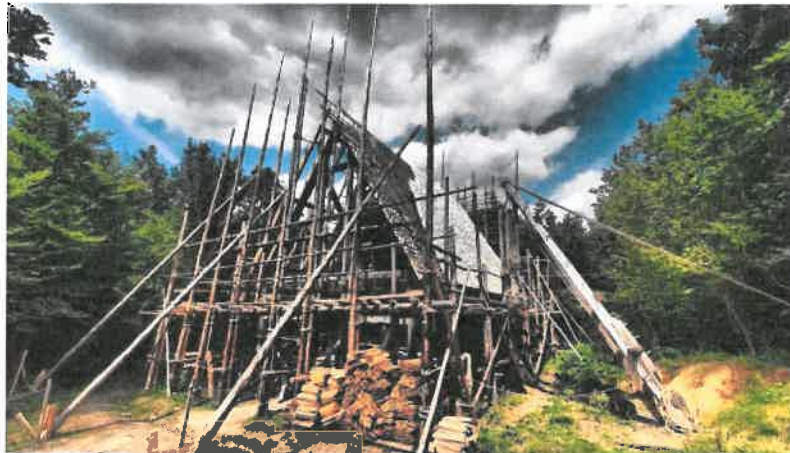
Schauen: Ein Rohbau ist schon fertig.
